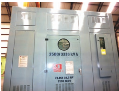
Transformador Encapsulado en Resina Epóxica Tipo Europeo
