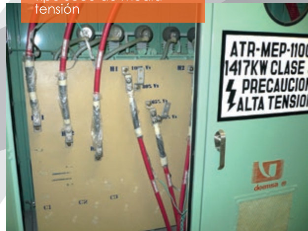
Autotransformadores de Tipo Seco de media tensión
